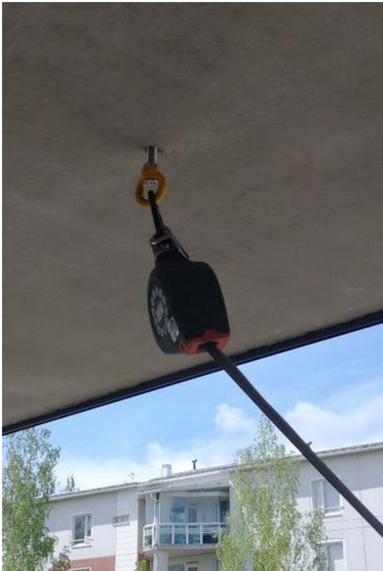
KUVA 10. Kiinnityspisteeseen liitetty liukutarrain
