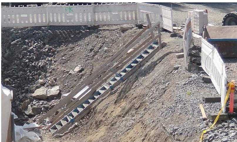
KUVA 4. Aidattu ja suojakaideportailta varustettu kaivanto.
