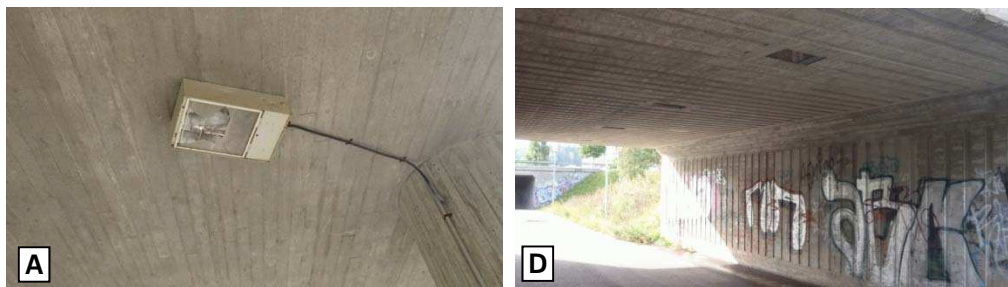
Kuva 19. Yksittäinen rikkiäinen valaisin ei vielä aiheuta toimenpiteitä (vasemmanpuoleinen silta), mutta useamman valaisimen rikkoutuminen (oikeanpuoleinen silta) on syytä saattaa tilaajan tietoon.
