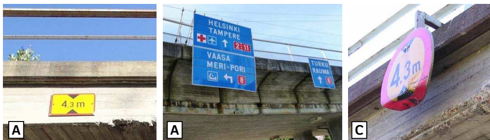
Kuva 20. Vasemmanpuoleisimman sillan alikulkukorkeutta osoittava merkki on kaikin puolin kunnossa eli vuositarkastusmerkintä kuuluu sarakkeeseen A. Keskimmäisessä sillassa liikennemerkki on saanut osuman, mutta on vielä hyvin luettavissa eli siinäkin oikea vaihtoehto on A. Oikeanpuoleisimmassa alikulkusillassa liikennemerkki on vahingoittunut törmäyksessä jo sen verran pahasti, että se on syytä uusida, joten oikea sarake vuositarkastusmerkinnälle on C.
