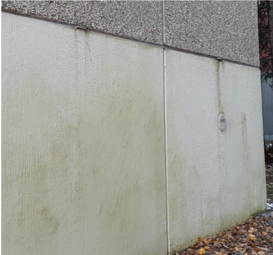
KUVA 8. Kohteen 7 julkisivun perusmuuri
