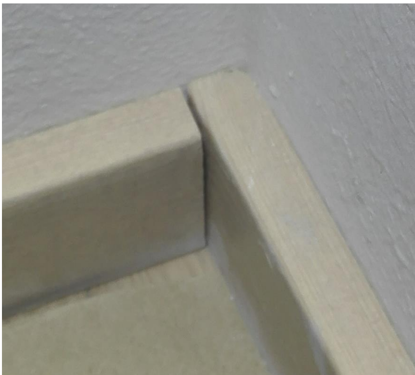
Kuva 20 Nurkassa listoissa rakoa
