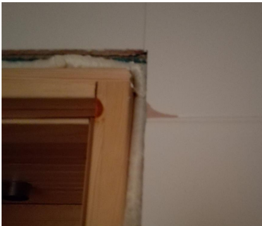
Kuva 18 Kolhiintunut laatta
