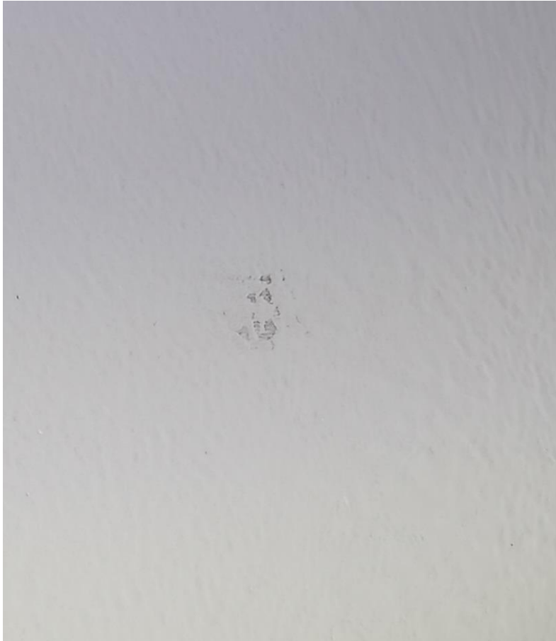
Kuva 13 Valmiissa seinä pinnassa jälki
