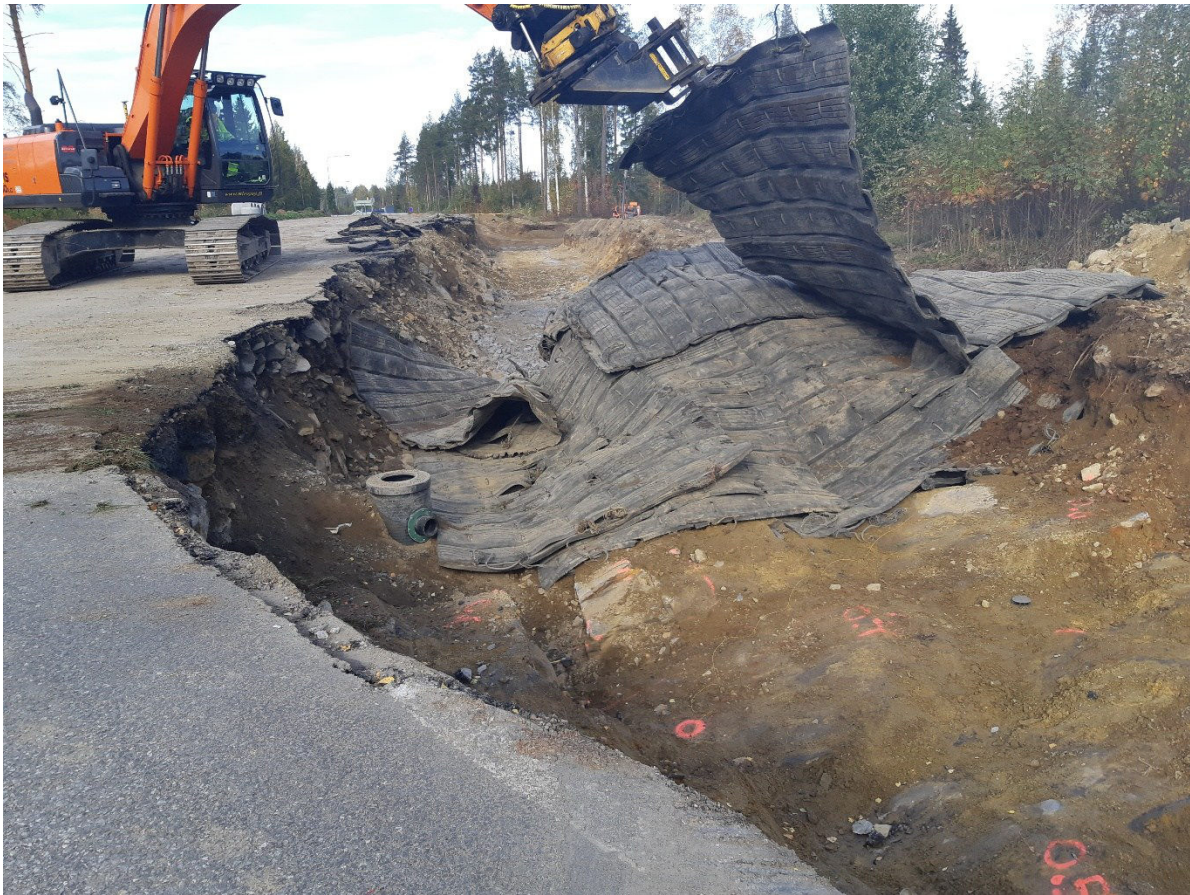
Kuva 4. Räjätysessä syntyvien kivensirpaleiden sinkoutumisen estämiseksi käytetään suojina kuorma-auton renkaista tätä tarkoitusta varten valmistettuja suojamattoja. (Kuva: Mika Savinainen)
